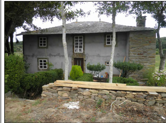
Casa Reitoral, fachada principal
